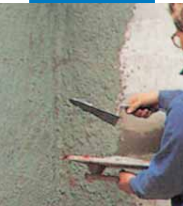
Нанесение цементных составов с добавлением Planicrete
