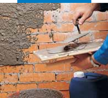
Связующий штукатурный слой с добавлением Planicrete
