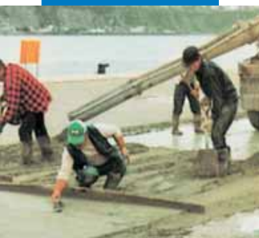
Цементная стяжка снаружи помещений с добавлением Planicrete
