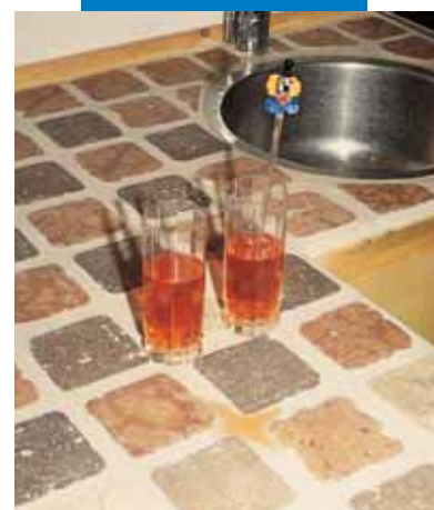
Пример приклеивания и заделки швов на кухонной стойке
