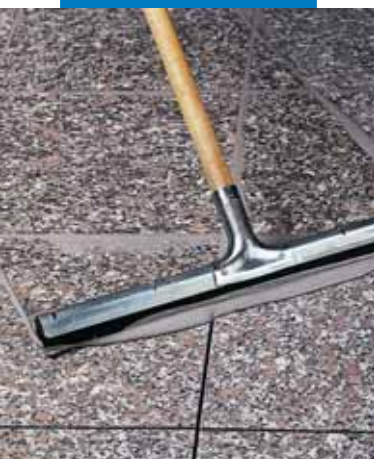
Шпаклевка полового покрытия из полированного гранита скребком
