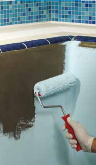
Нанесение Elastocolor Waterproof валиком
