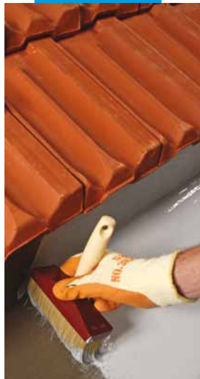
Образец водосточного желоба, загидроизолированного Mapelastico Smart и окрашенного Elastocolor Waterproof
