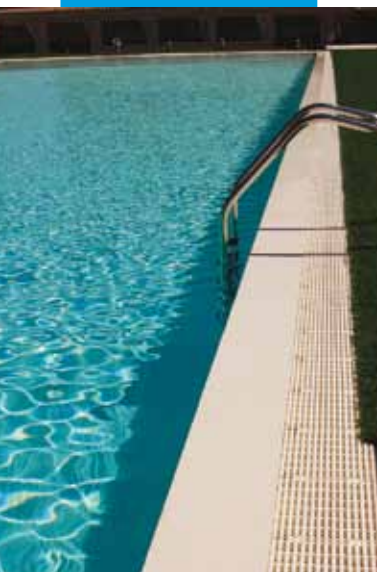
Вид бассейна, окрашенного Elastocolor Waterproof
